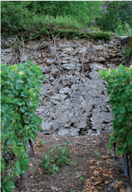
Fig. 15. Mur de vigne en gypse, Ollon.
