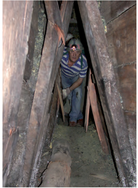
Fig. 5. Boisages en partie détruits par le gonflement de l'anhydrite dans la galerie des cristaux de sélénite à l'étage du Coulat, mines de Bex en août 2002. Photo Joël Brugger & William (Bill) Birch, Melbourne.
