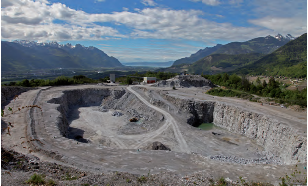
Fig. 13. Carrière du Montet, vue en direction N (photo S. Ansermet).
